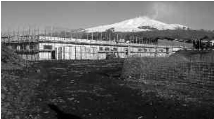
Vista della struttura sottostante il campo in erba sintetica, nella struttura sono previsti: spogliatoi, palestre, sale benessere, centro medico sportivo, garage, ...
