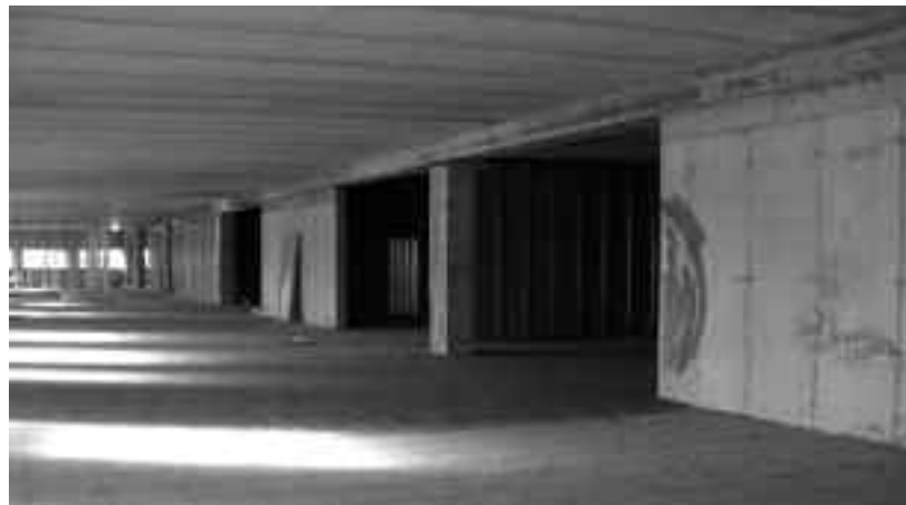
Dentro la struttura sottostante il campo n. 3 in erba sintetica
